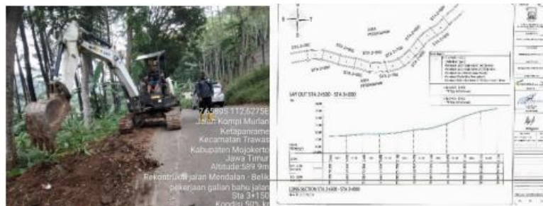
Gambar 3. Pekerjaan Galian Bahu Jalan
