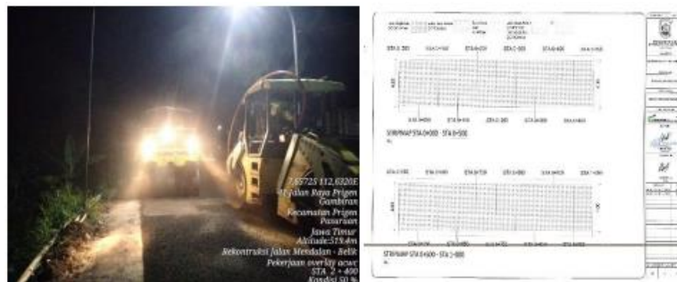
Gambar 2. Pekerjaan Overlay AC-WC
