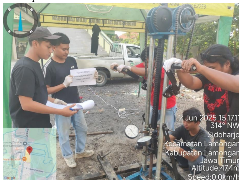
Gambar 5. Dokumentasi Uji Sondir Titik 2
