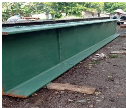
Gambar Pengadaan dan pemasangan Baja WF
