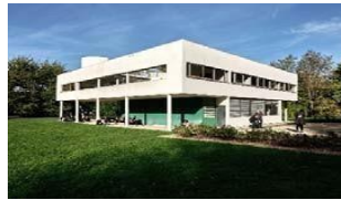
Gambar 13 Desain Bangunan Pilotis
